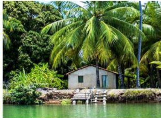
Habitação localizada às margens do Rio São Francisco
